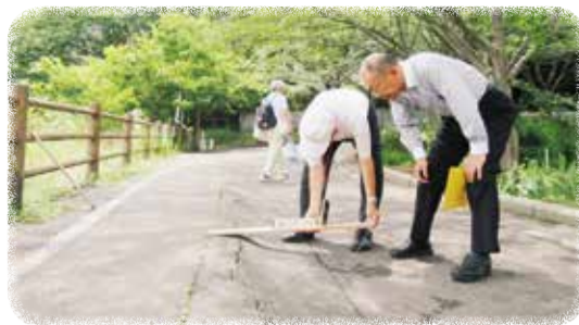
7月7日 地元の日本共産党地域支部と長津川調節池の遊歩道の段差やびび割れを調査する丸山慎一県議(右)
