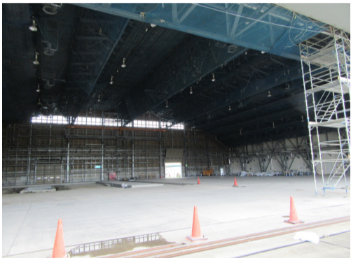
オスプレイの定期整備を行う格納庫の受け入れ工事 8月24日・木更津市
