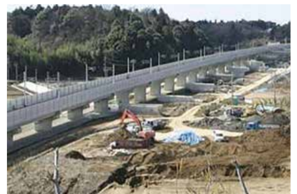
建設中の北千葉道路(千葉県ホームページより)
